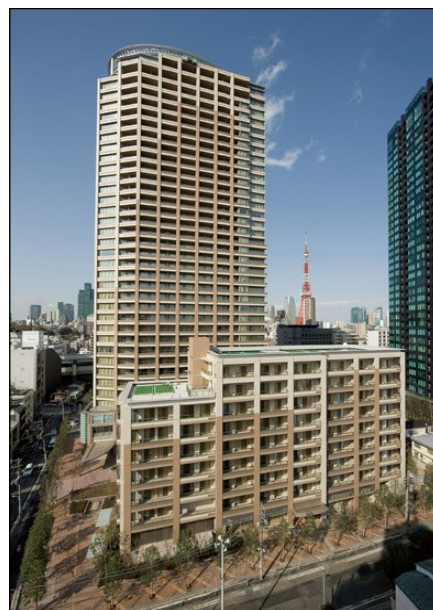
3. 三井不動産 パークコート麻布十番 設計：RIA・久米設計 施工：大成建設 外壁PC カラー着色 MSAA-1500 防汚・耐候 東京都港区 2010.5
