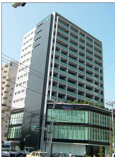
4. ヒューリック荏原ビル 設計：松田平田設計 施工：大成建設 外壁PC カラー着色・MSAA-1500 防汚・耐候 東京都品川区 2010.8
