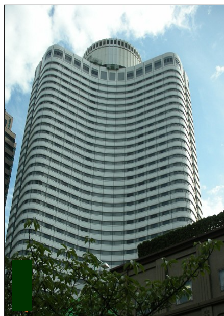
5. ホテルニューオータニ タワー塔 設計：大成建設 施工：大成建設 塔屋PC改修 カラー着色MSAA-1500 防汚・耐候 東京都港区 2010.9
