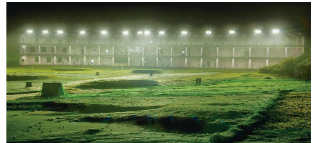
100ヤード付近より北打席をのぞむ。屋根上に設置されている高出力形LED投光器(レディオック フラッド デュエル1000W)は狭角と広角の2種類の配光をバランス良く組み合わせ、フェアウェイを均斉度のとれた光で照らし出している。 Looking at the north tee-off area from the 100-yard mark. The high-output LED floodlights (LEDioc FLOOD DUELL 1000W) installed on the roof have a good balance of both wide and narrow light distribution and light the fairway in a symmetrical light.
