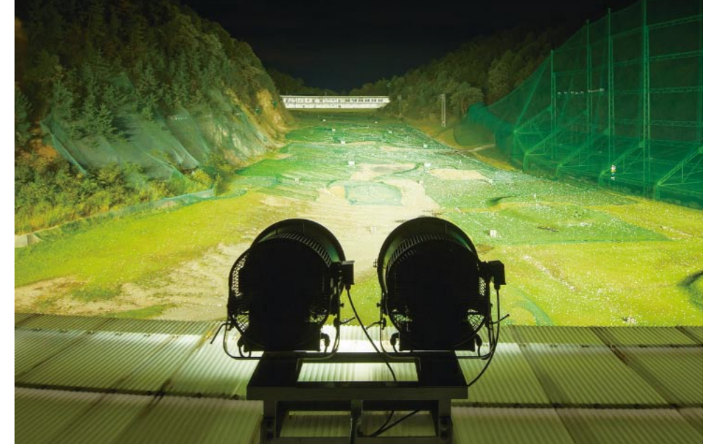
大幅な省エネを実現する高出力形LED投光器(レディオック フラッド デュエル1000W)で350ヤードのフェアウェイを照らし出し、250ヤード付近で100lx、100ヤード付近で200lxの鉛直面照度を確保。打球の視認性を高めている。 The high-output LED floodlights (LEDioc FLOOD DUELL 1000W) have made large-scale power savings a reality, lighting the 350-yard fairway and ensuring vertical plane lighting of 100lx at the 250-yard mark and 200lx at the 100-yard mark.
