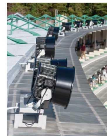
屋根上に設置されている高出力形LED投光器(レディオック フラッド デュエル1000W)。 The high-output LED floodlights (LEDioc FLOOD DUELL 1000W) installed on the roof.
